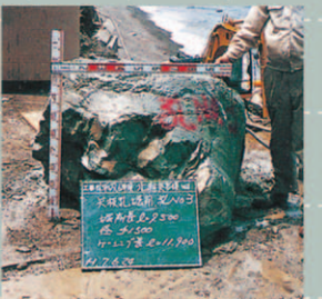
障害物撤去 場所打杭撤去
