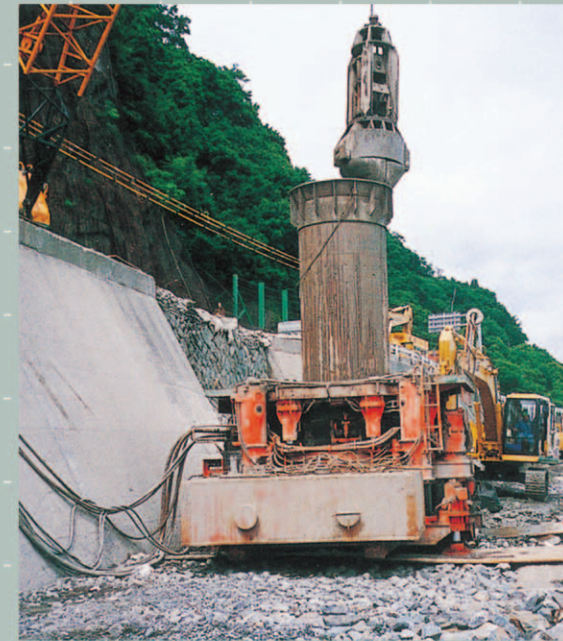
転石岩盤掘削
