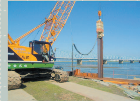
● ハットチャック工法 (特殊矢板900ピッチ)
